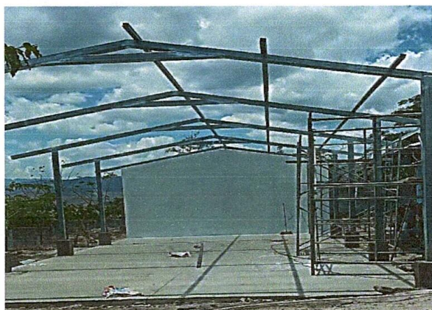
Foto 3: Durante el proceso de mejoramiento con Estructura tipo pórtico e instalación de lámina troquelada calibre 26 en salón de reuniones y mejoramiento de piso
