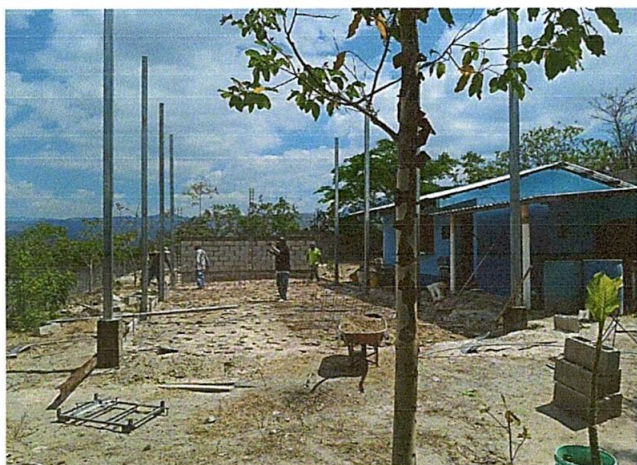
Foto1: Durante el proceso de mejoramiento con Estructura tipo pórtico e instalación de lámina troquelada calibre 26 en salón de reuniones y mejoramiento de piso
