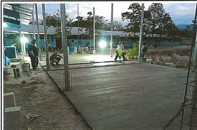
Foto 4: Durante el proceso de mejoramiento con Estructura tipo pórtico e instalación de lámina troquelada calibre 26 en salón de reuniones y mejoramiento de piso
