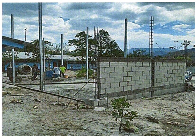
Foto 2: Durante el proceso de mejoramiento con Estructura tipo pórtico e instalación de lámina troquelada calibre 26 en salón de reuniones y mejoramiento de piso
